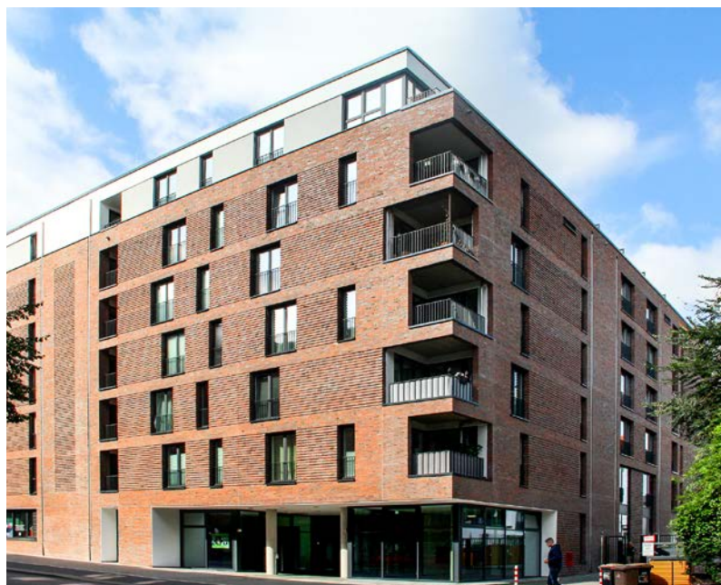
Ein bequemer und barrierearmer Zugang zu den Fahrradstellplätzen ist von großer Bedeutung. Beim Kieler Neubau der Gewoba Nord ist die Fahrradgarage im Erdgeschoss über einen gesicherten Hofeingang erreichbar
